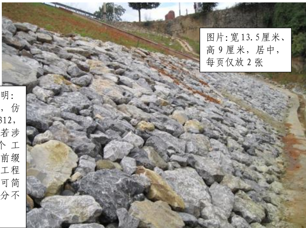
× × 质量管理图 1-1 贴坡排水砌筑全貌
